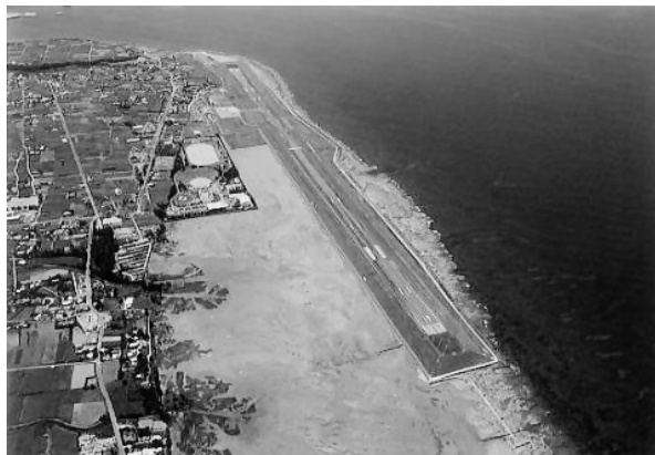
（徳之島空港、写真手前側・北側に長い埋立地があり、それを使って滑走路を延長すれば3000メートル滑走路が出来る。鹿児島県の徳之島空港紹介ページより 14 ）
